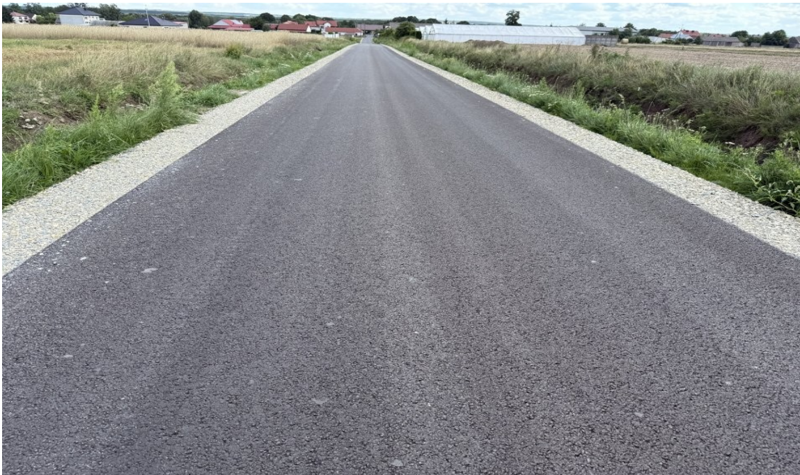
Droga po remoncie w miejscowości Paskrzyn
