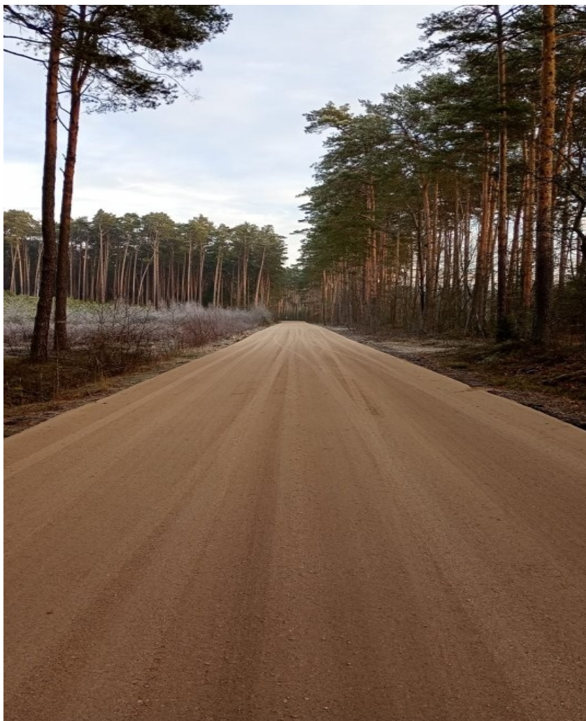
Droga po remoncie w miejscowości Stobnia (Trzy Morgi)
